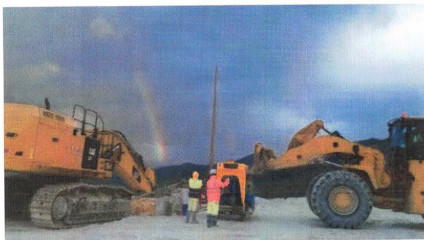
Mezzi d'opera presso la cava
