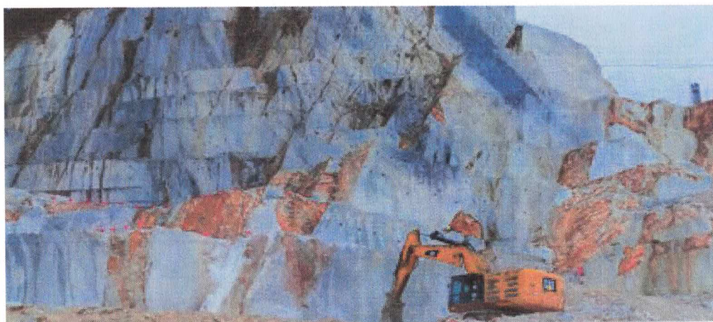
Foto del fronte di cava, che evidenzia lo stato di fratturazione
