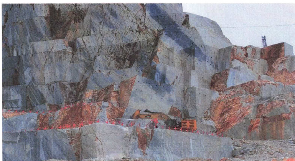
Foto del piazzale in lavorazione
